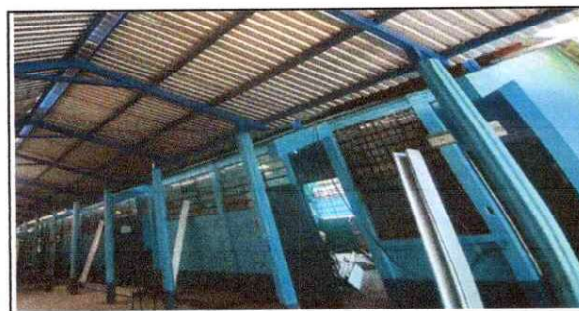
foto 5: Sustrución de canal de metal
