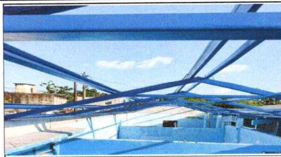
foto 2: Mantenimiento a estructura de soporte de metal
